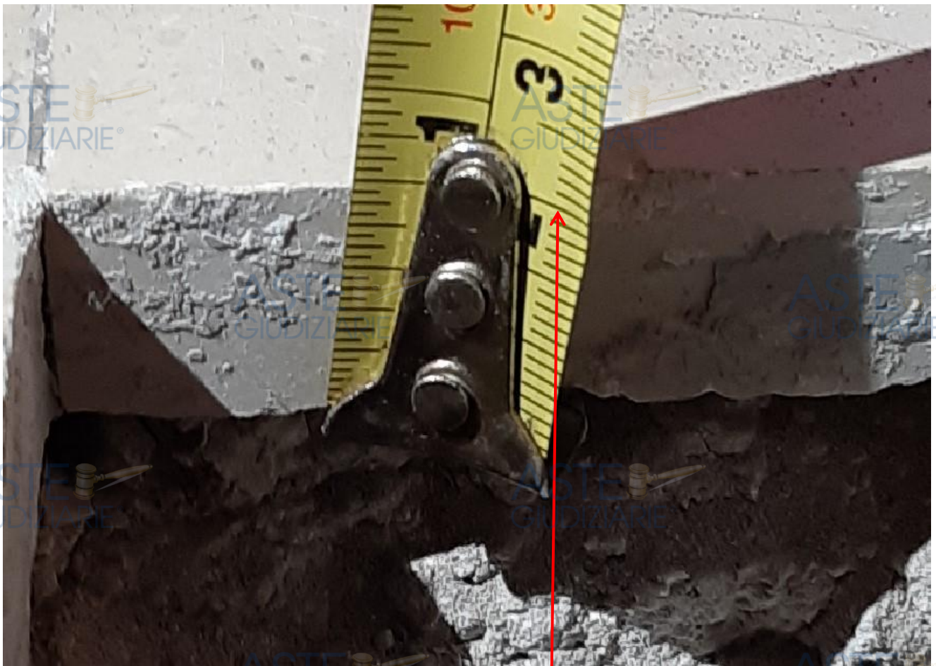
Foto 6 (Spessore pavimento 2 cm.)
