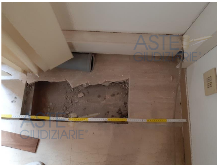
Foto 1 Locale a ridosso del cortile condominiale (saggio nella pavimentazione)
